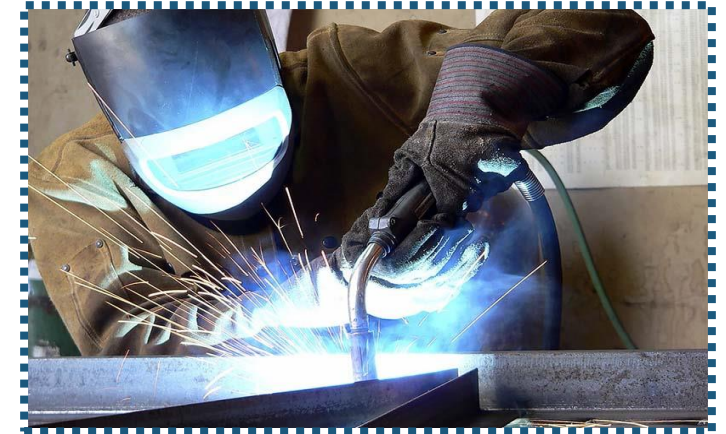
Газо- и электросварочные работы
